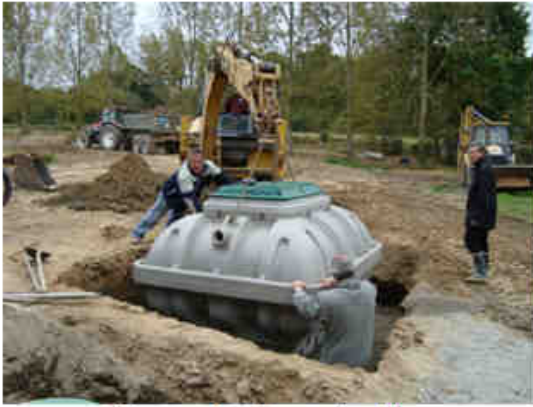
Figure 4 : Pose du filtre
