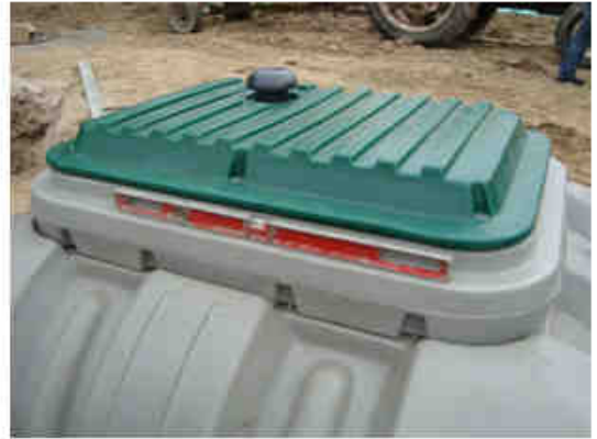
Figure 5 : Vérification des niveaux
