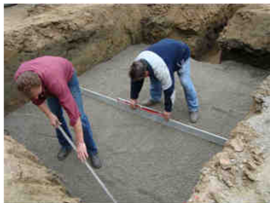
Figure 3 : Nivellement du gravier
