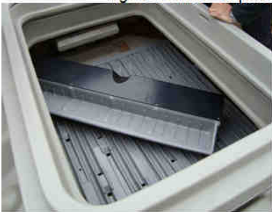
Figure 7 : Vérification horizontalité coco + mise en place auget et plaques
