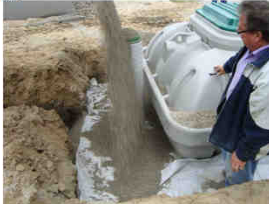
Figure 6 : Mise en place du géotextile anticontaminant et remblai
