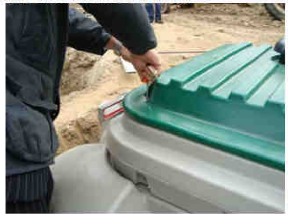
Figure 8 : Finale, plaque isolante et verrouillage couvercle
